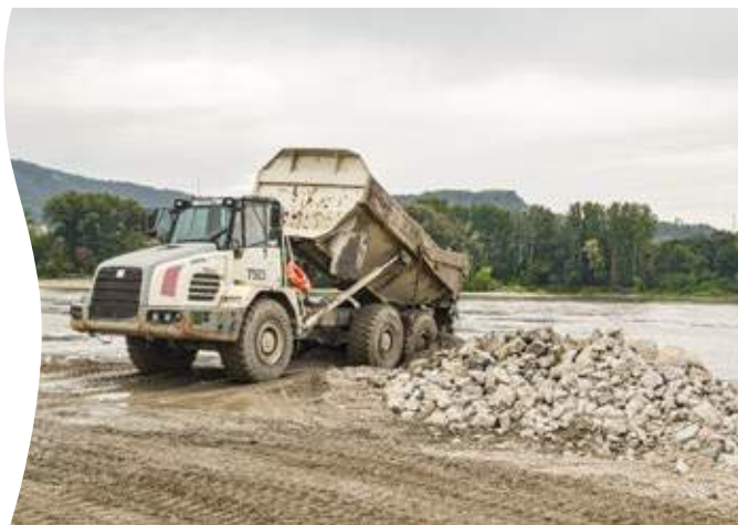
Lagerung von Flussbausteinen an der Donau für den Abtransport mit Schiff
