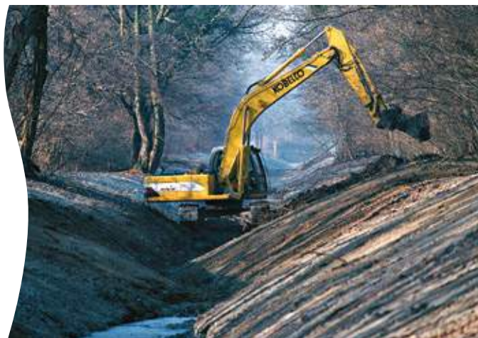
Bauarbeiten zur Revitalisierung des Fadenbachs, circa 2000
