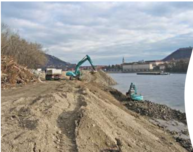
Entfernung von Wasserbausteinen entlang der künstlichen Uferlinie
