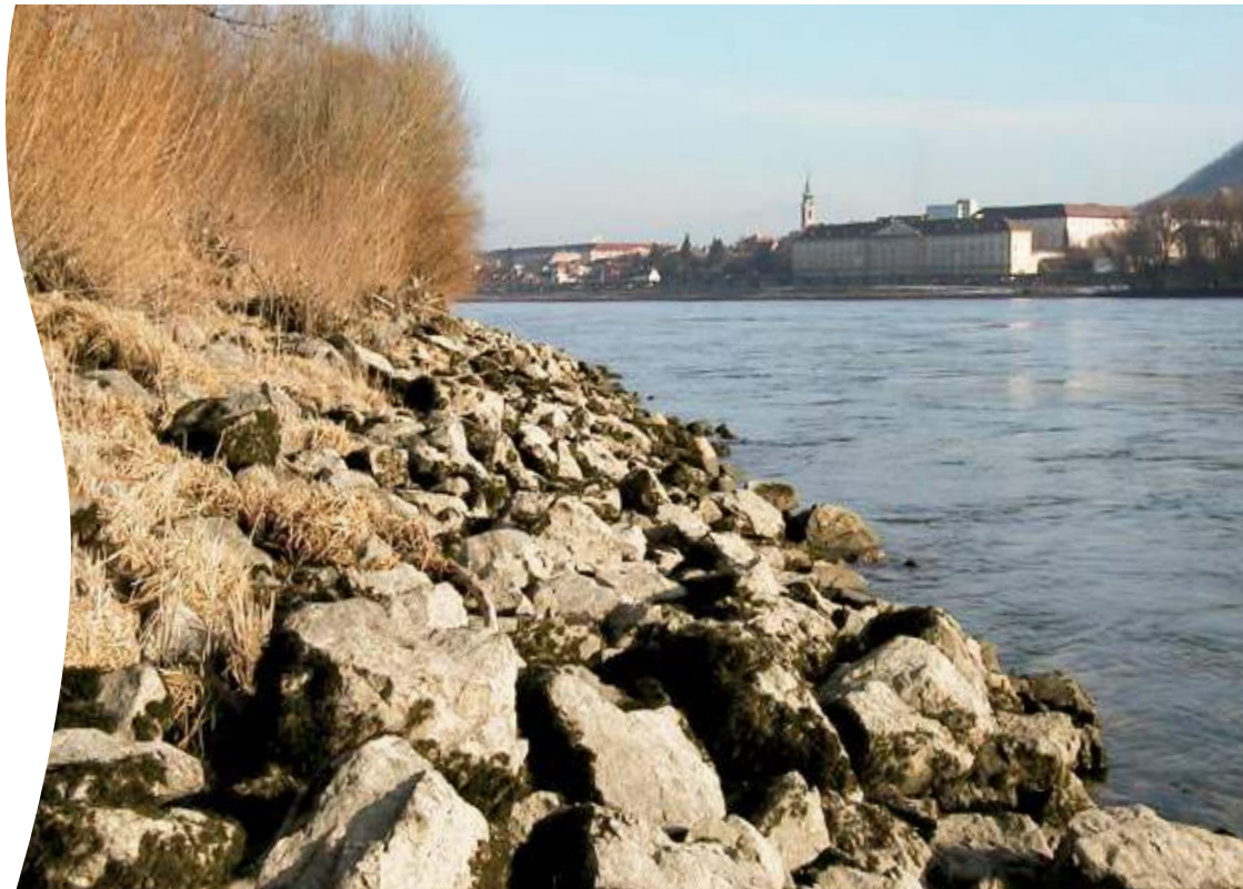
Durch Wasserbausteine künstlich befestigtes Donauufer
