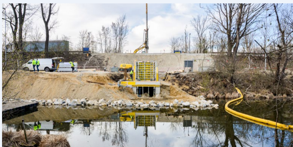
Eine neue Rohrleitung speist künftig Wasser aus der Neuen Donau in die Obere Lobau ein.
