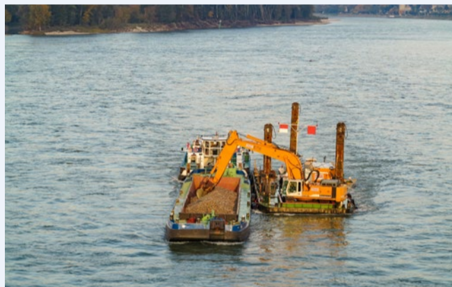
Laufende Erhaltungsbaggerungen sowie die Zugabe von Schotter sichern stabile Schifffahrtsverhältnisse.
