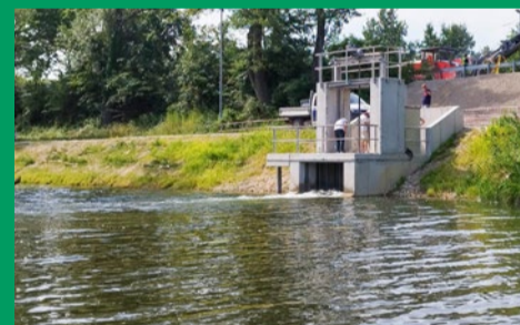
Durch eine Rohrverbindung wird die Lobau aus der Neuen Donau dotiert.
